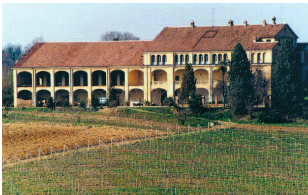
Cascina Pappalarda, tipico esempio di struttura rurale monferrina, citato e studiato su diversi manuali di architettura.
